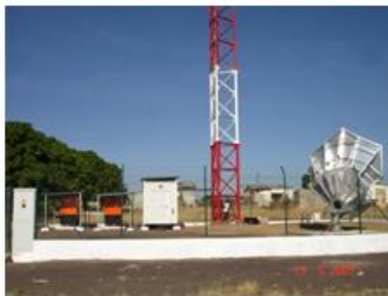
GSM backhaul site, Kuito
